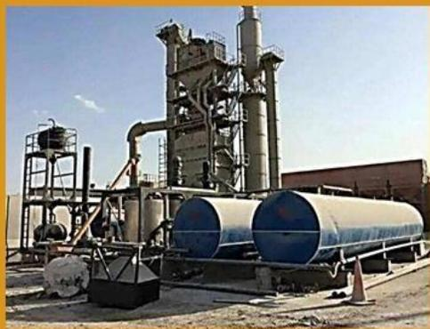
L'unité de production de bitume est conçue pour produire du bitume de qualité spécifique par oxydation directe du goudron provenant de l'unité de distillation sous vide du fioul.
