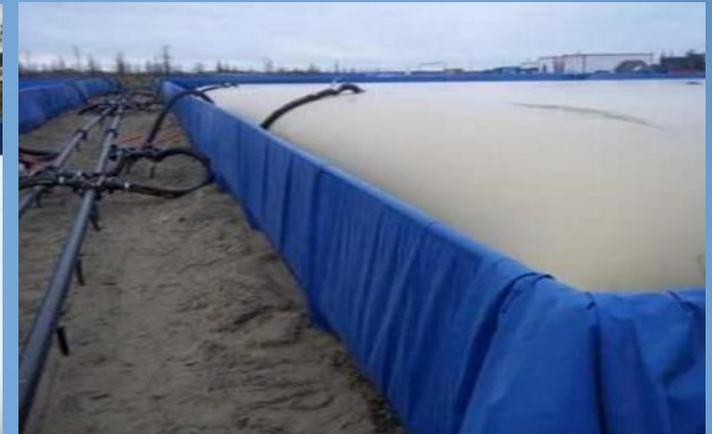
Les réservoirs élastiques en polymère sont destinés au stockage et au transport de carburéacteur, de kérosène d'aviation, de carburant diesel, d'essence, d'huiles de moteur et de pétrole brut sur le terrain, à des températures ambiantes de moins 60 °C. La hauteur des réservoirs élastiques en polymère est de 1,70 cm.
